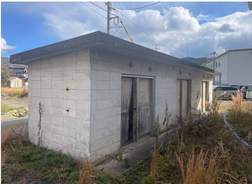
B棟東側倉庫②
