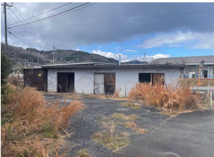
A棟北側倉庫①
