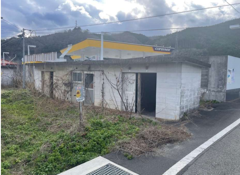
A 棟西側倉庫②
