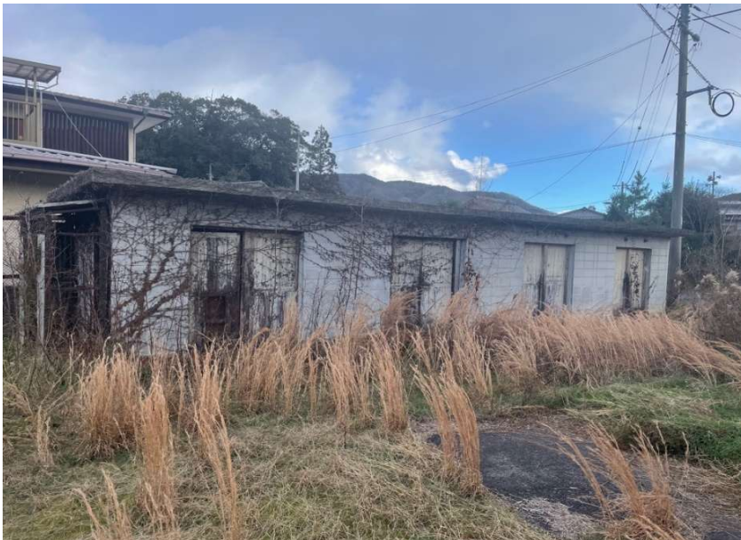
C棟東側倉庫
