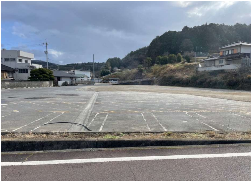
本庁舎跡地西面
