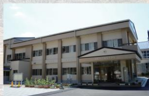
加美小学校大規模改修工事開始
